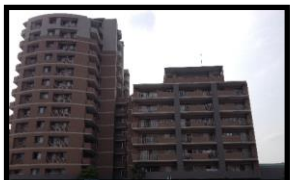
駅前ロータリーに面した 分譲賃貸マンション
